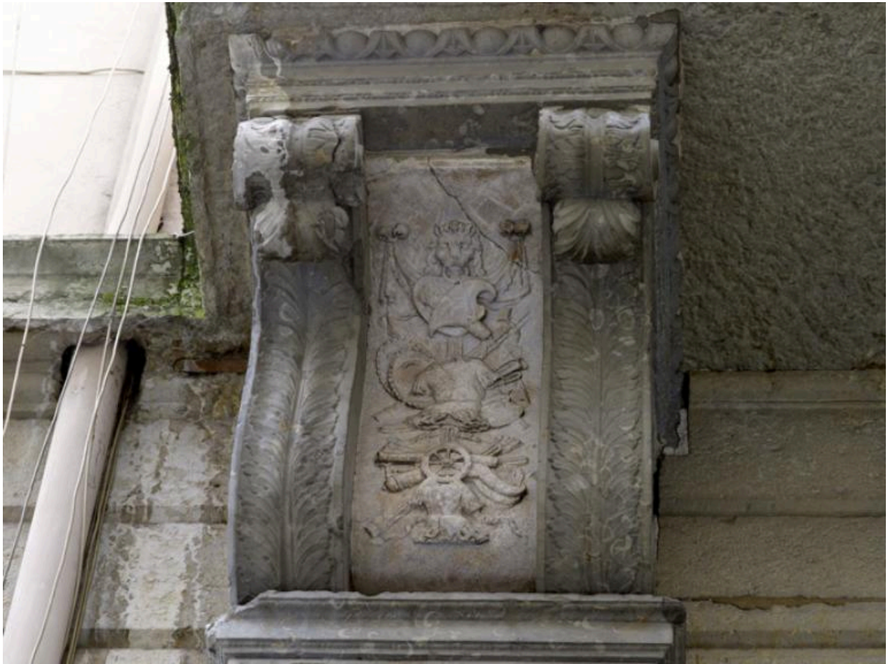
Portail : balcon, console gauche, vue de face
