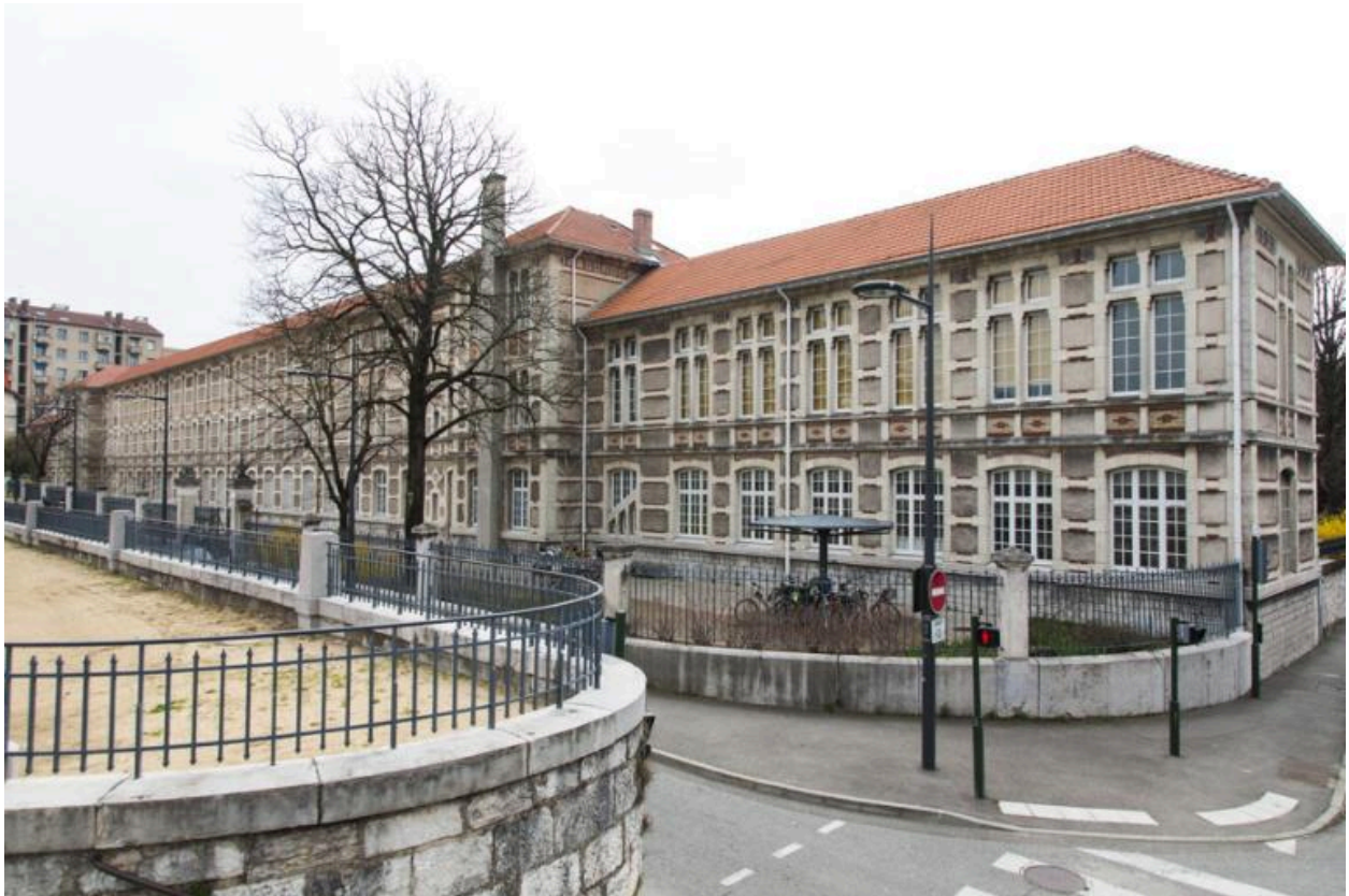
Bâtiment nord : façade nord
