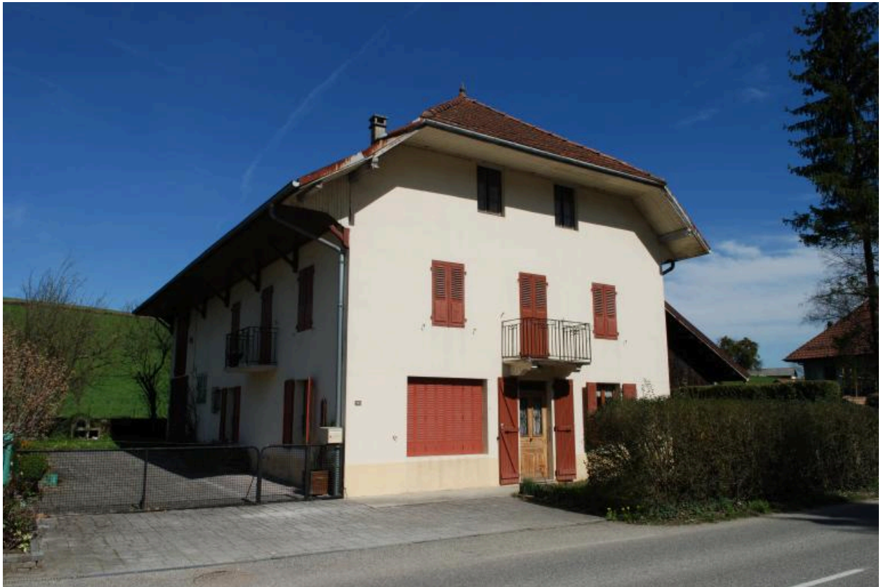
La Fay-est, 2015 B3 1251, ferme, vue d'ensemble de trois-quarts avant gauche
