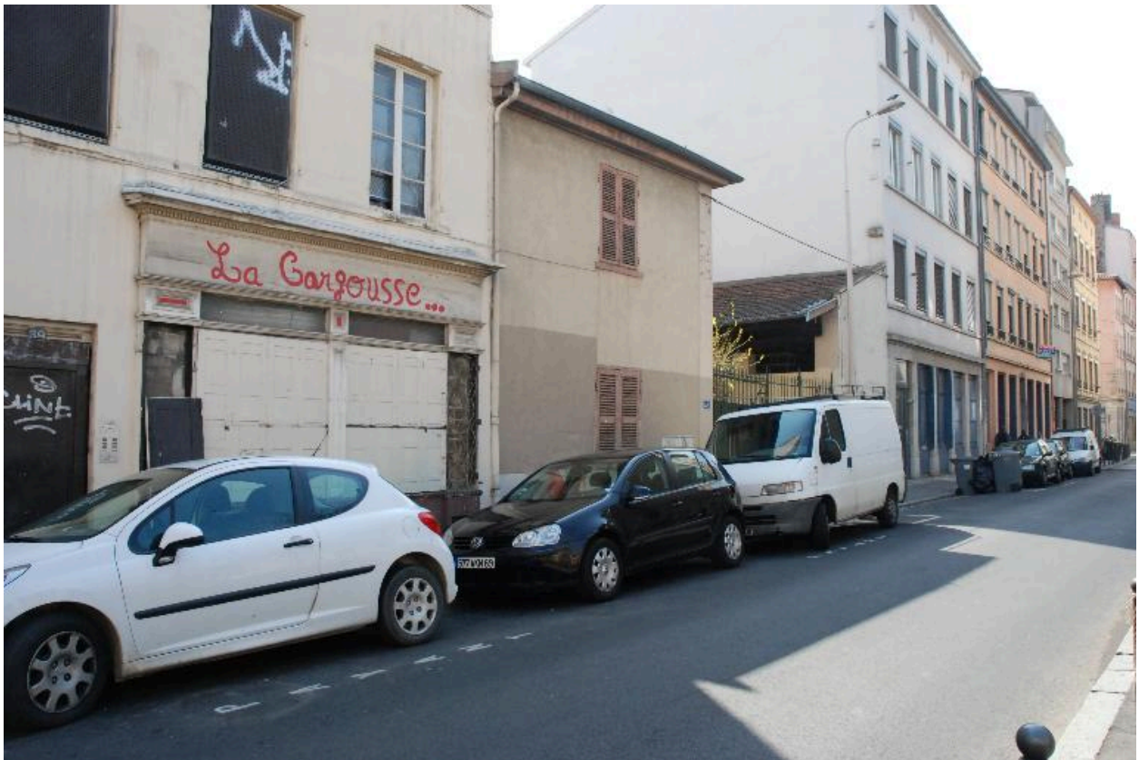
Bâtiments démolis (état 2012)
