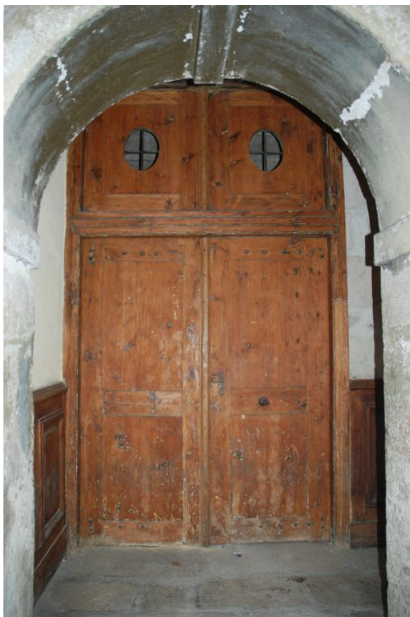
Porte d'accès au sous-sol depuis la cour.
