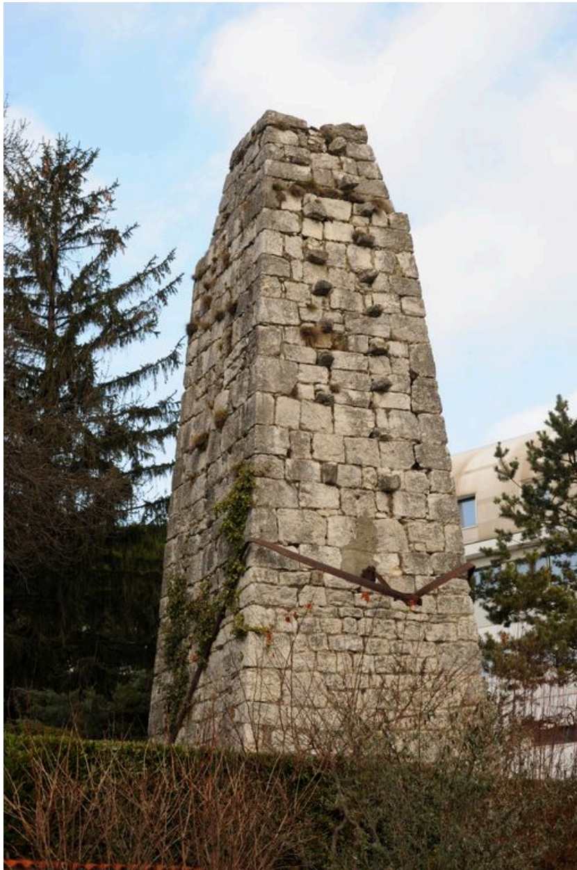
Pile subsistante en rive droite, vue générale
