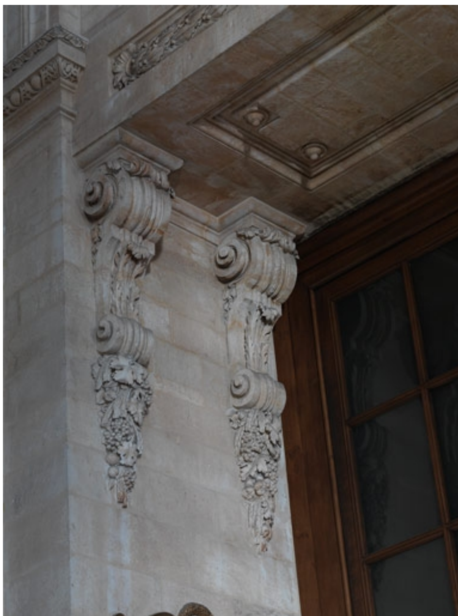
Détail des modillons de l'encadrement des portes de l'étage
