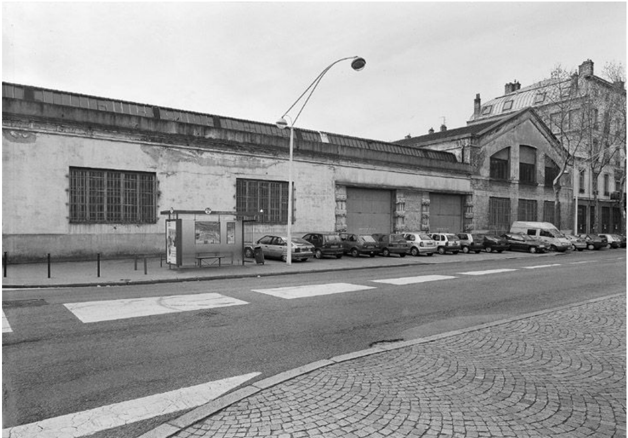
Vue de la façade nord
