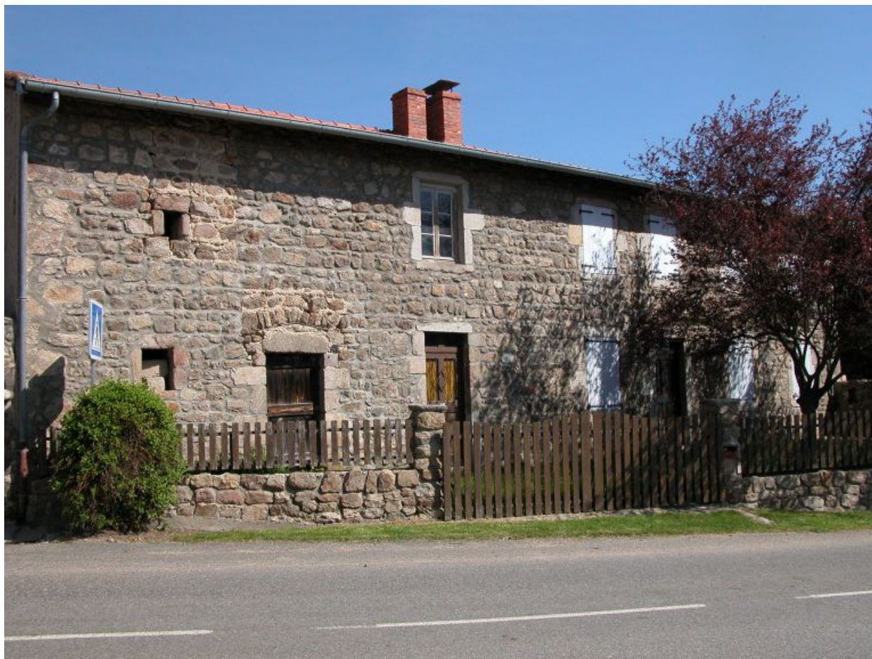
Vue d'ensemble de la façade principale avant.
