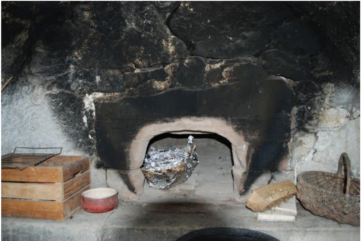
Détail de la bouche du four à pain.
