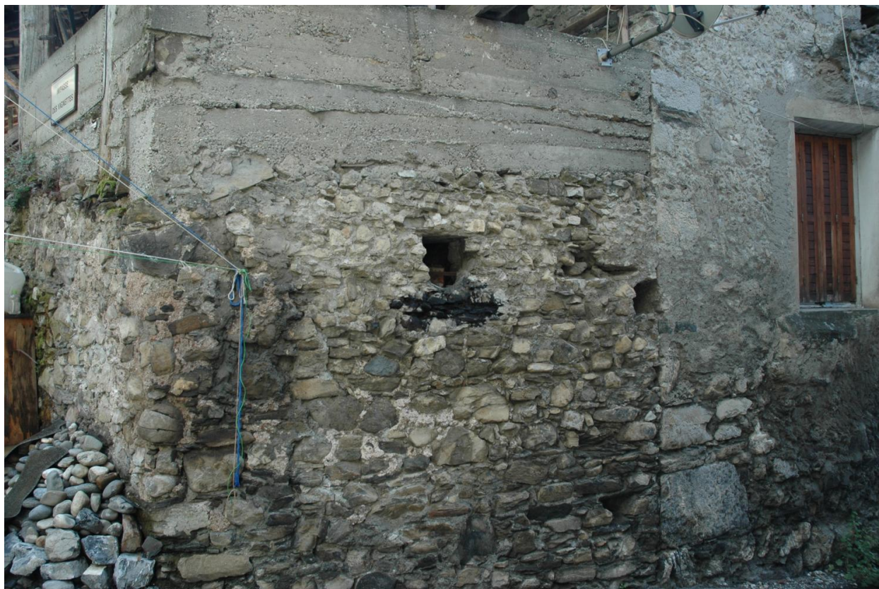
Détail de l'angle sur l'impasse des Carrières / impasse des Vignettes.
