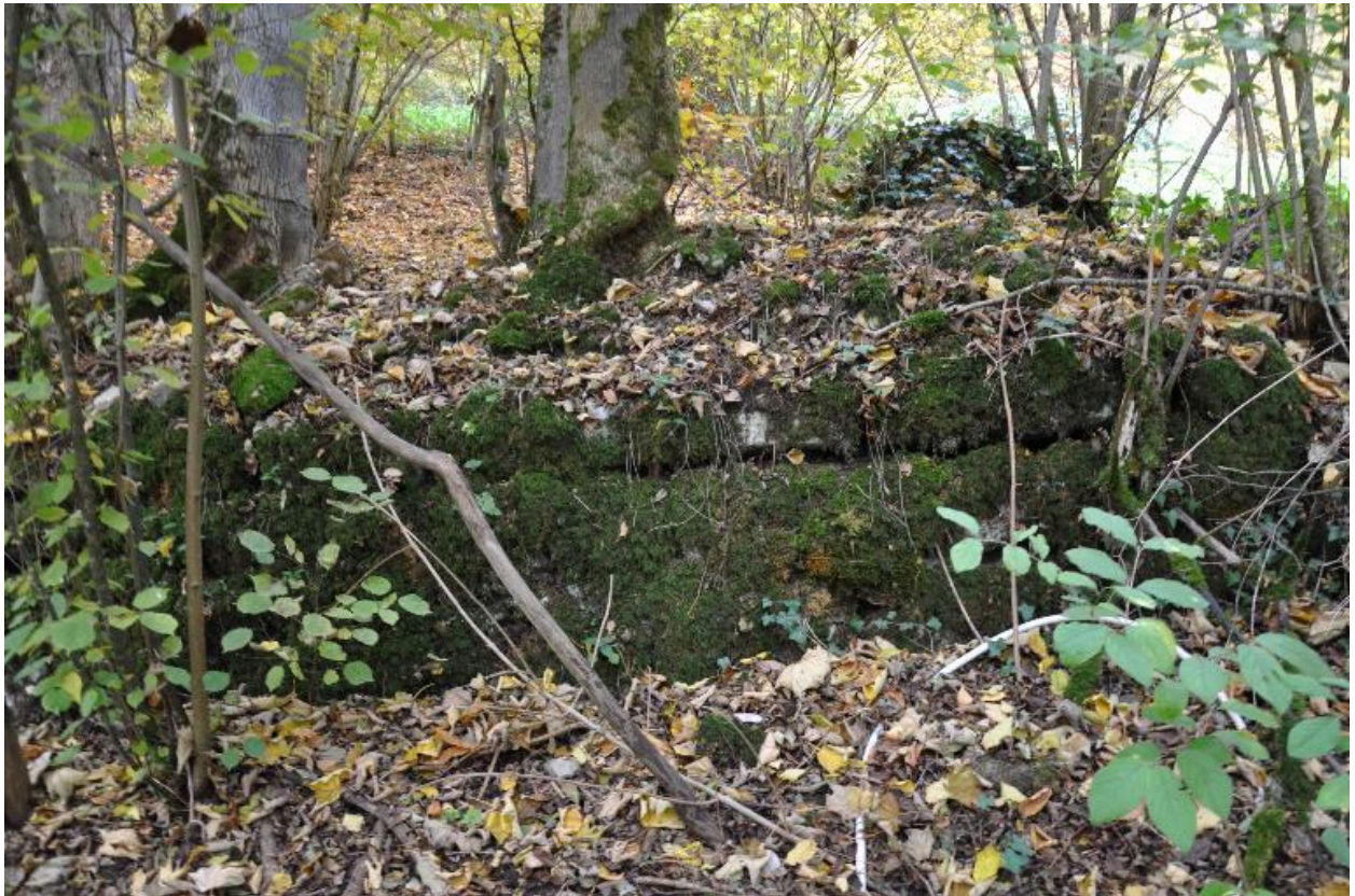
Murs de soutènement réalisé en pierre sèche se trouvant en amont des moulins de Dhéré
