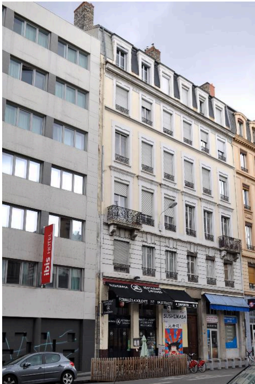
Vue générale, élévation sur rue
