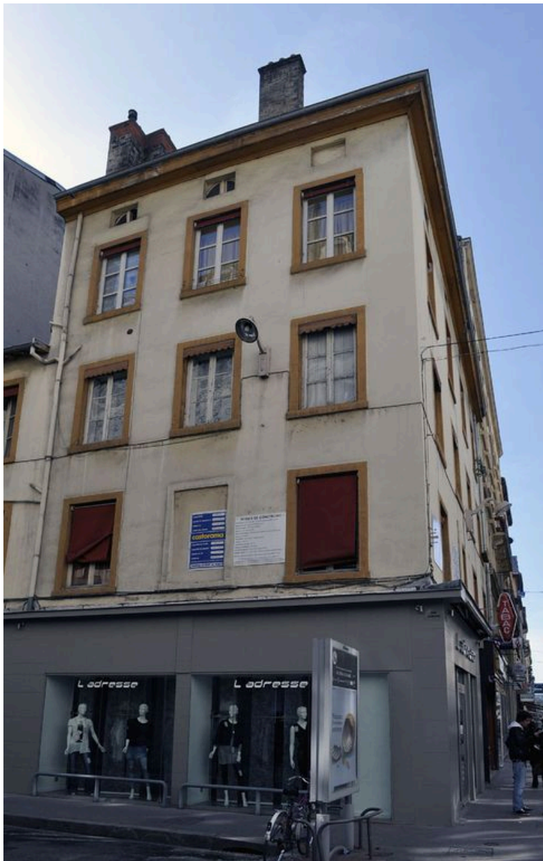
Elévation latérale nord, partie droite
