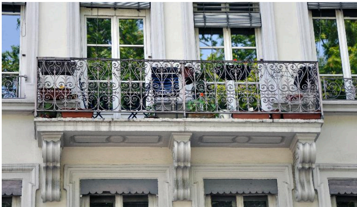
Vue rapprochée : le balcon du deuxième étage carré
