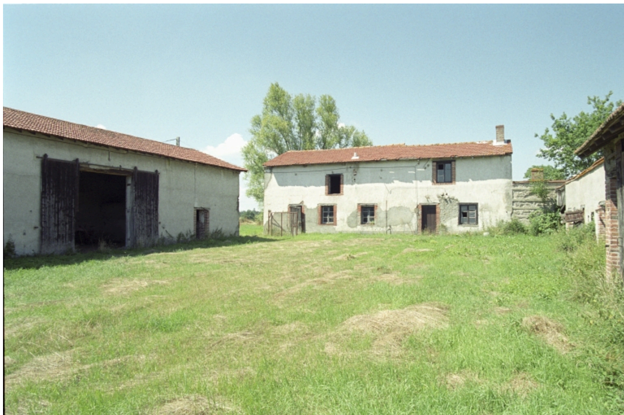
Sainte-Foy-Saint-Sulpice, à Bardet (1986 B1 107), type C3. Vue d'ensemble de la cour.
