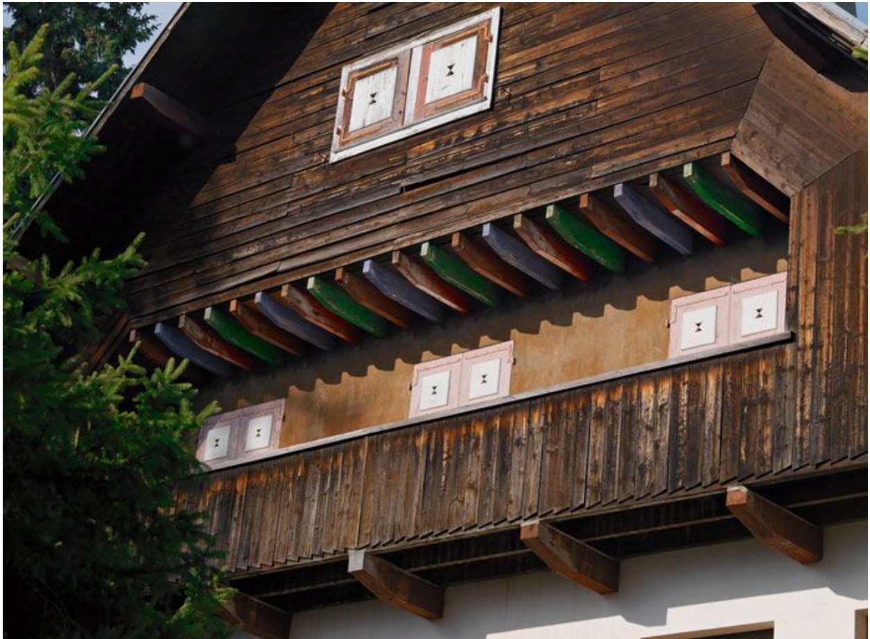
Vue de la loggia ouest
