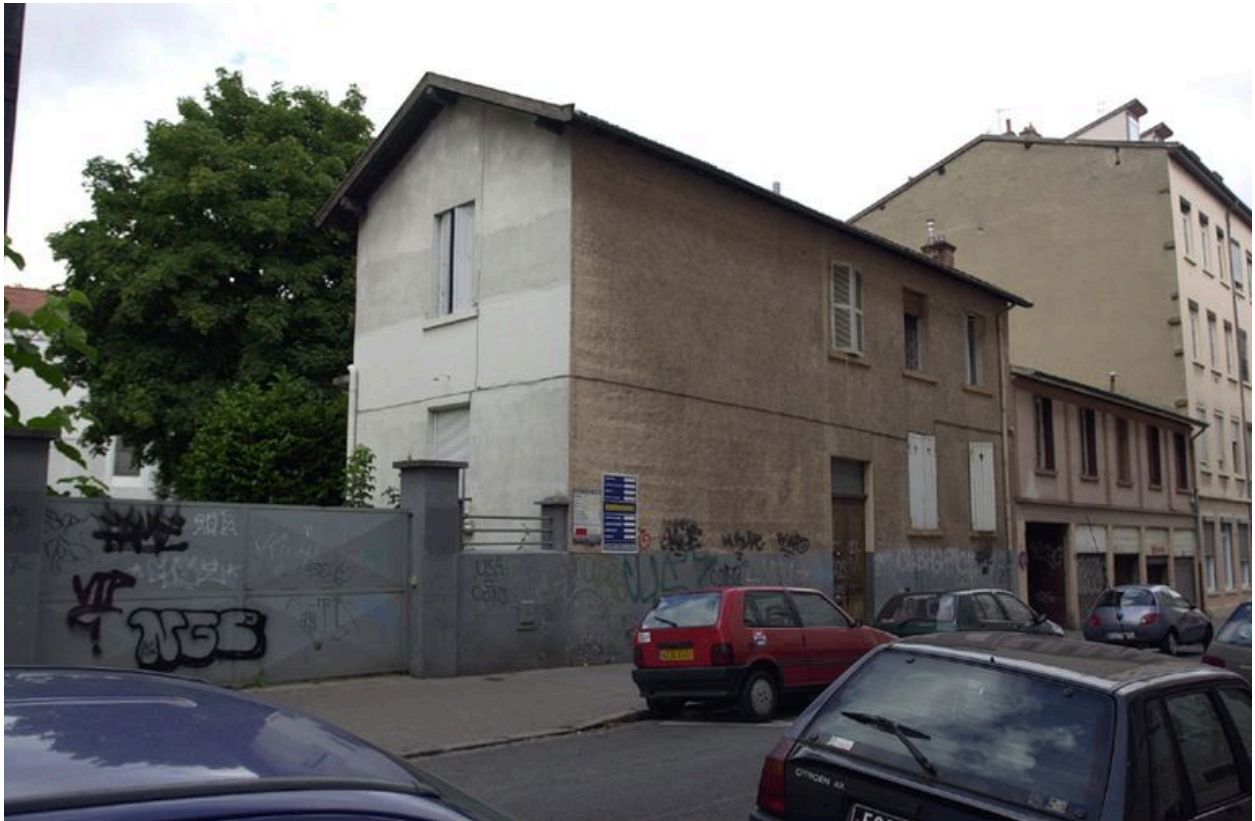
Vue générale des bâtiments de logements et de garages depuis la rue
