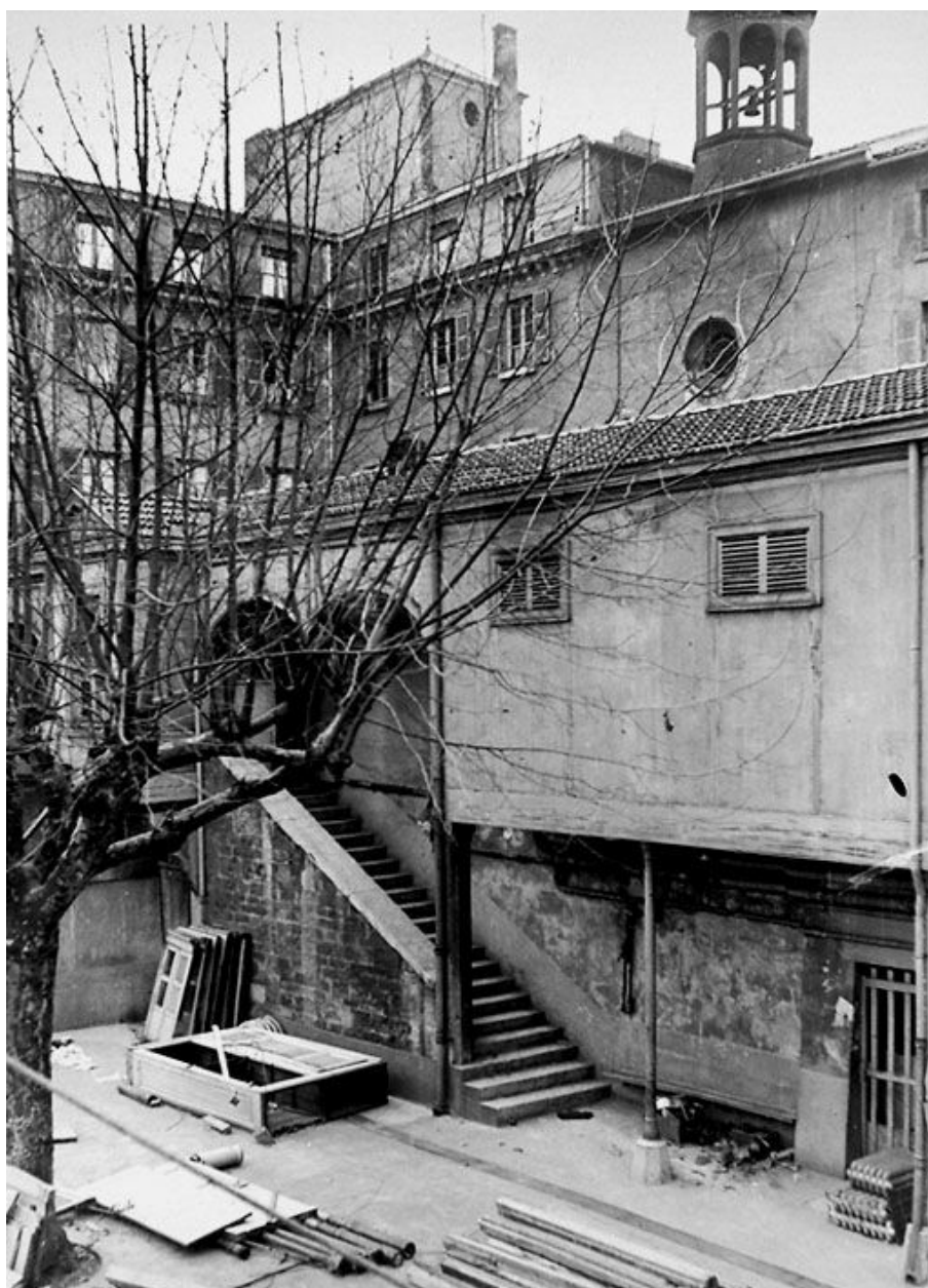
Antiquaille. Démolition du bâtiment de la Rotonde. 1. Détail de l'aile sis entre les terrasses 10 et 11, 1935
