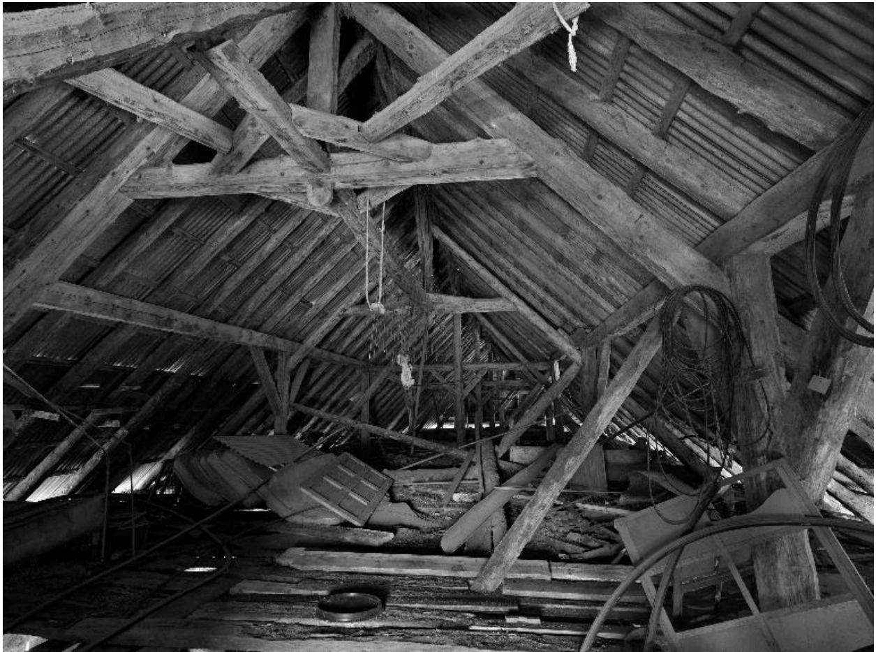
Vue intérieure de l'étable : la charpente.
