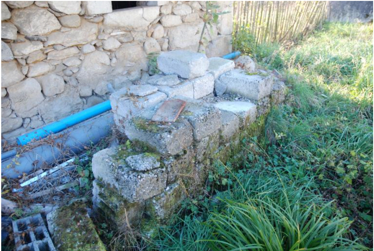
Parpaings de béton artisanal entreposés à côté d'une ferme au hameau de Crêt Sale.
