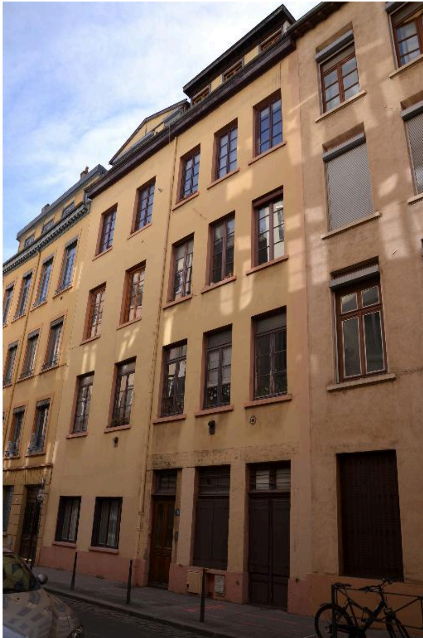
Vue d'ensemble façade nord
