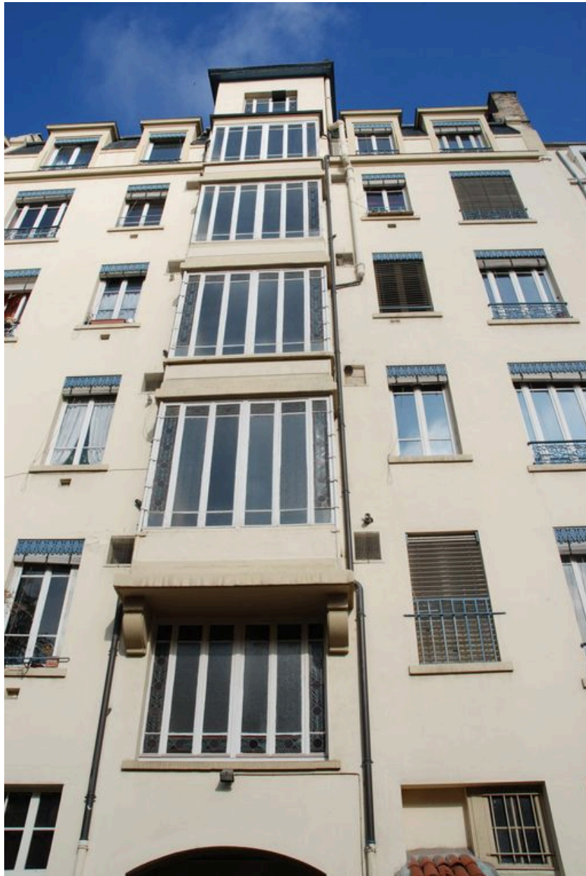
Vue du revers, avec la cage d'escalier vitrée
