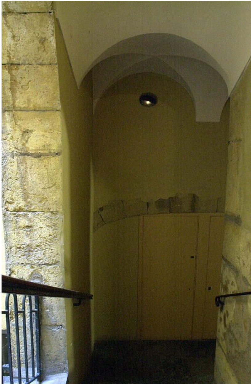
L'escalier : détail d'un repos avec arcade occupée par un placard et voûte d'arêtes
