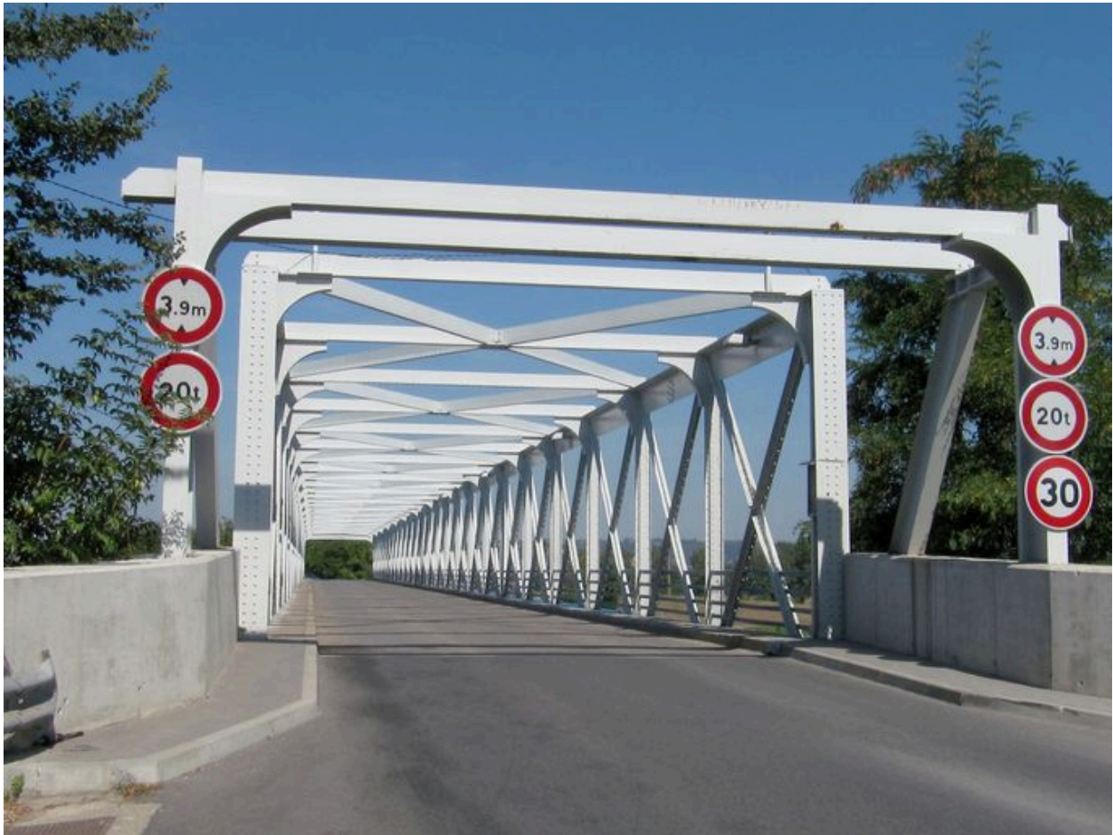
Vue générale, de dessus, chaussée et structure métallique (depuis la rive gauche)
