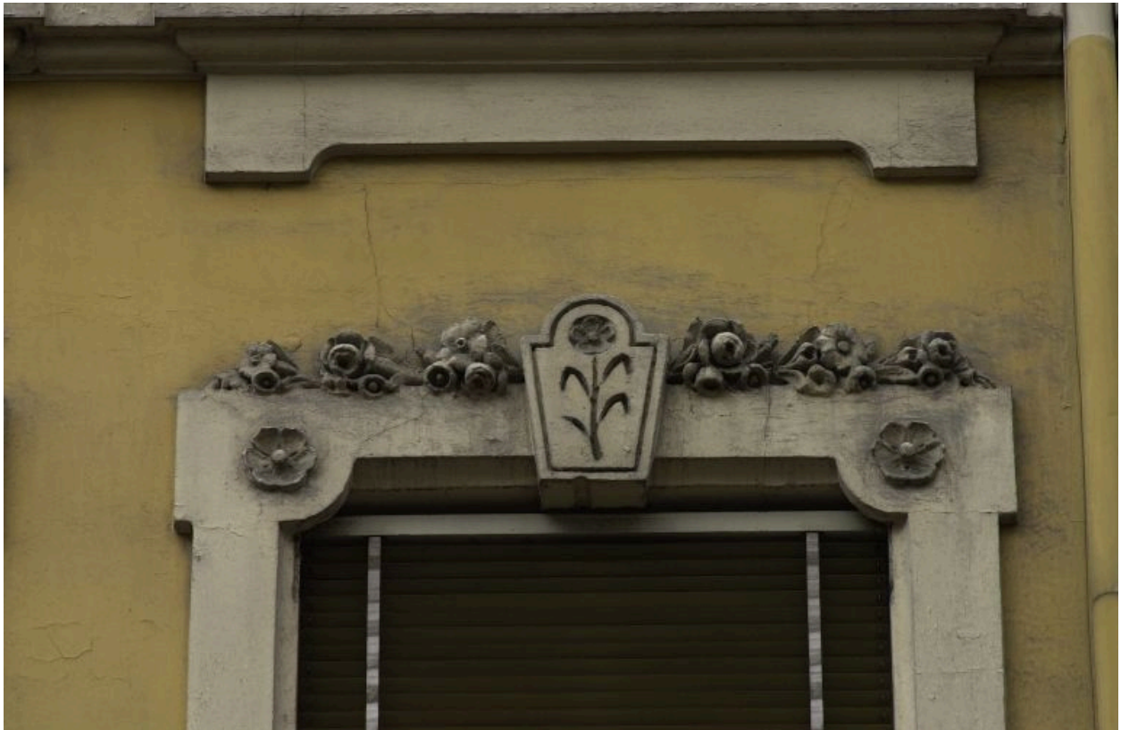
Façade principale, partie gauche, 3e niveau, détail de la fenêtre centrale
