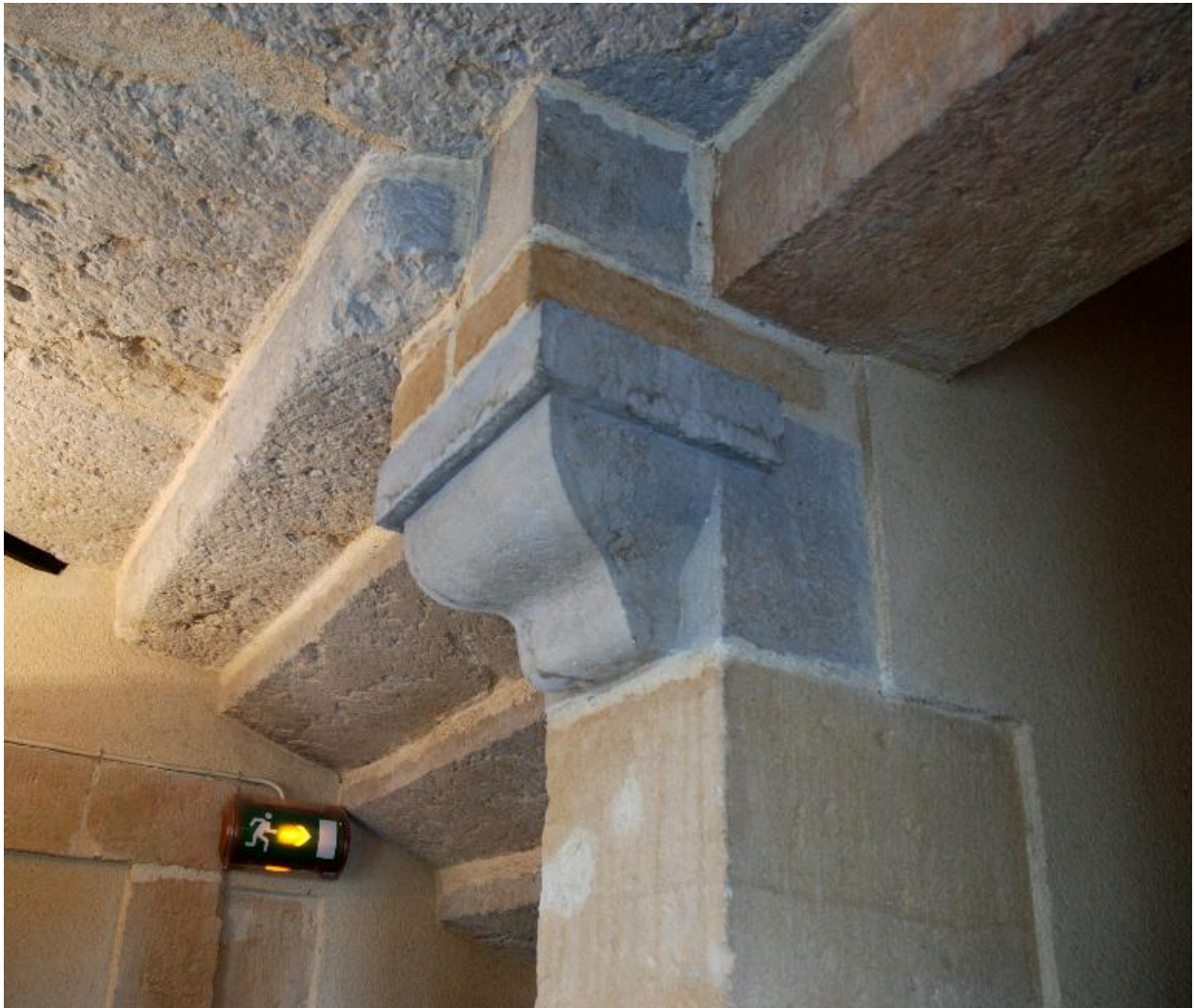
Escalier A, mur noyau, détail d'une console
