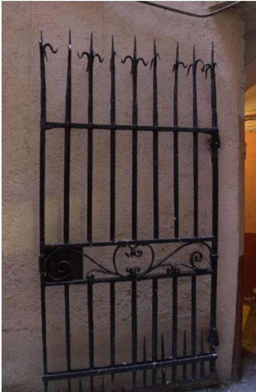
Cour, grille en fermant l'accès depuis l'escalier
