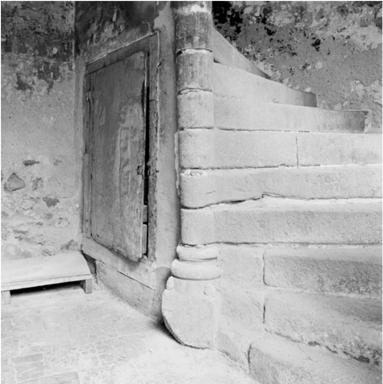
Puits sous le départ de l'escalier en vis, corps de bâtiment sur cour.
