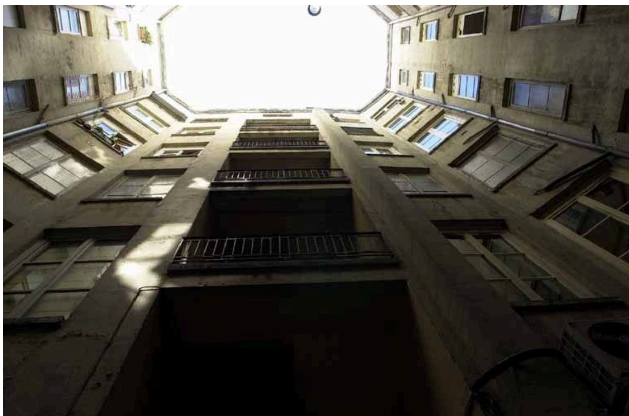
La cour : élévation est, avec la travée d'escalier
