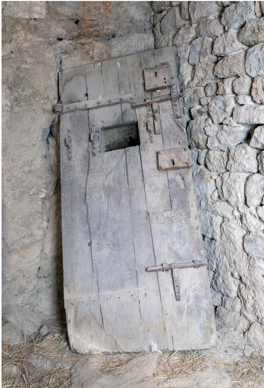
Aile nord, sous-sol : rampe d'accès, ancienne porte d'un cachot ?
