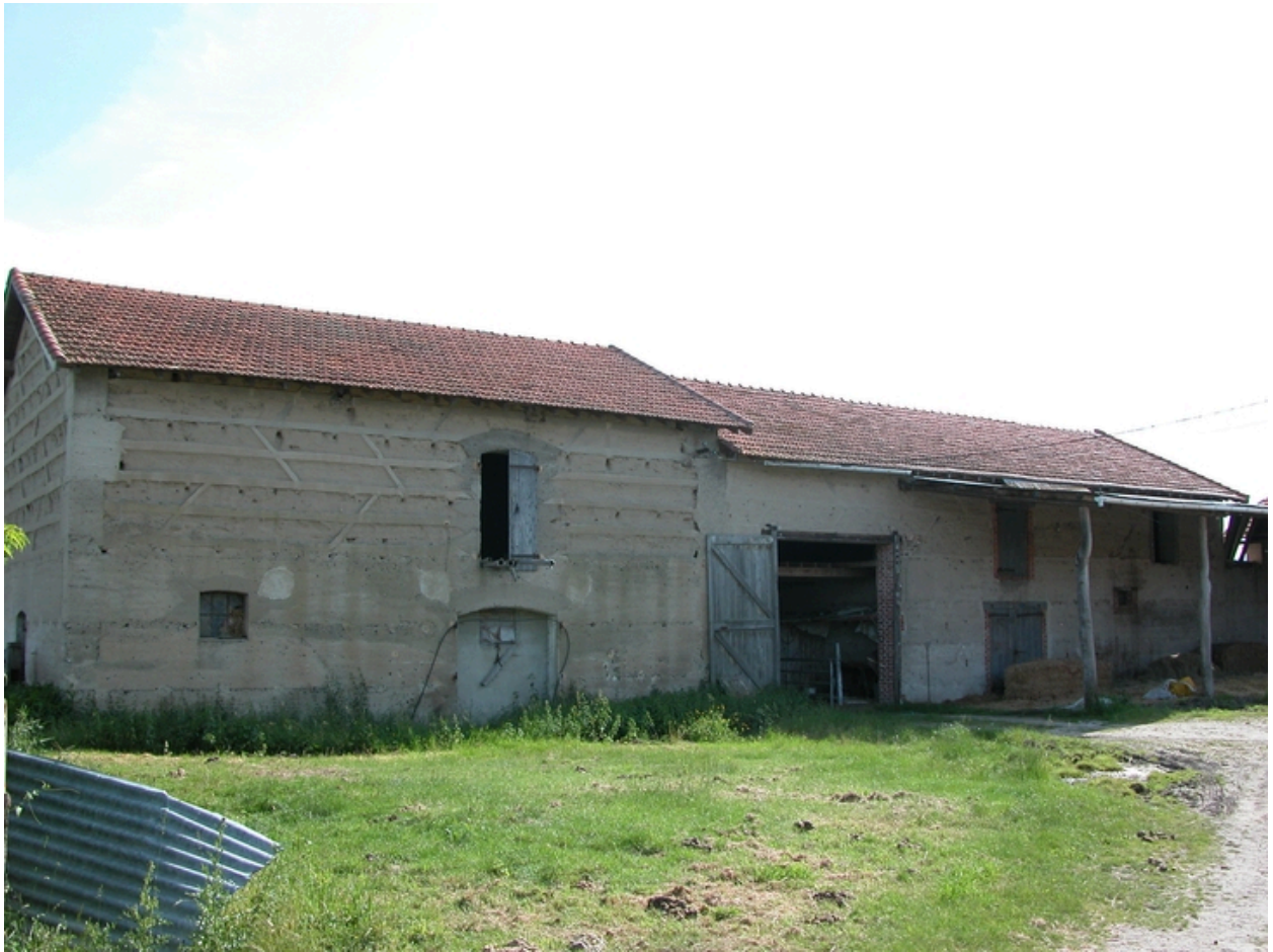
Vue de la grange-étable et de l'étable et fenil.
