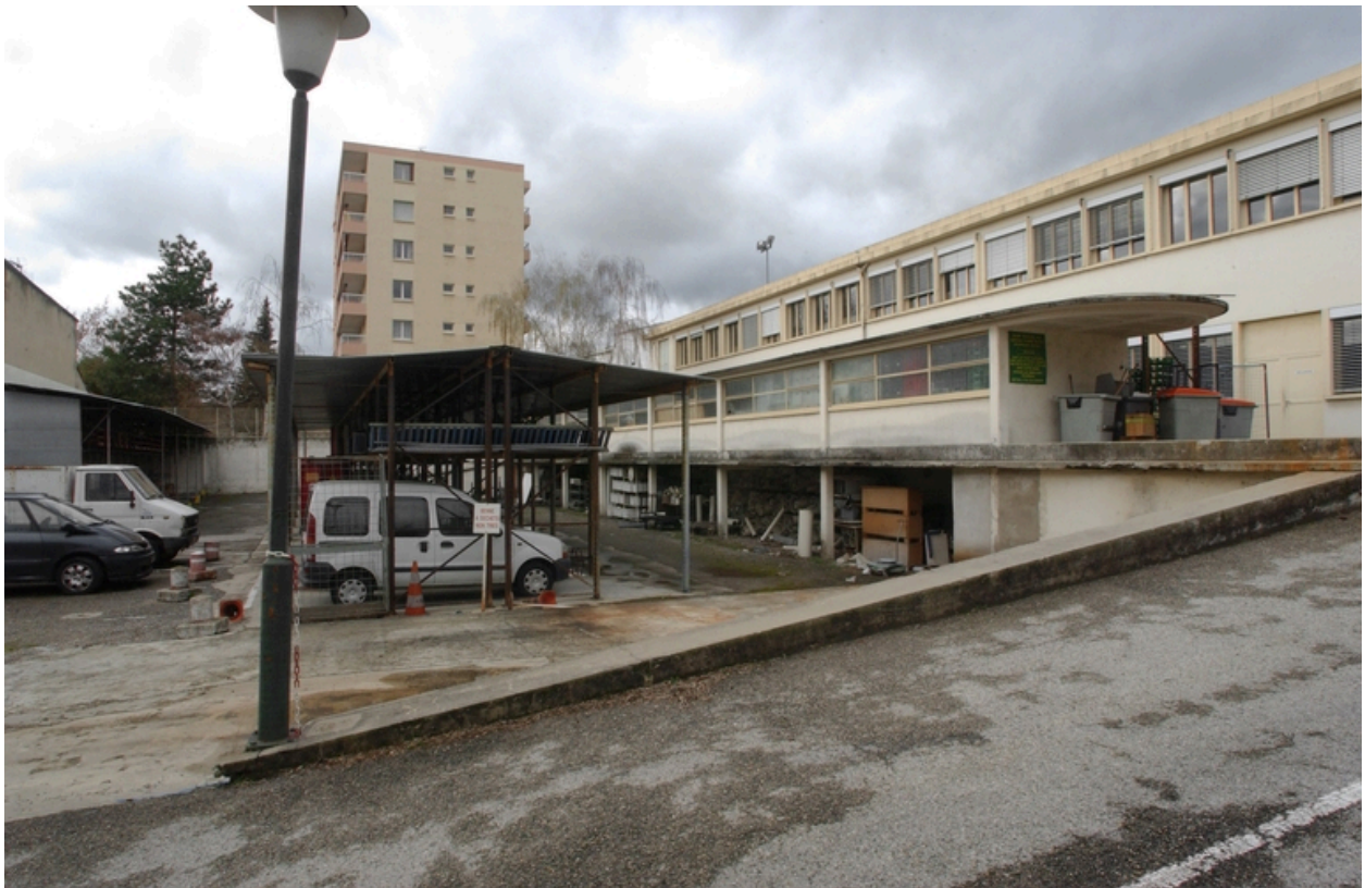
Vue extérieure des bâtiments
