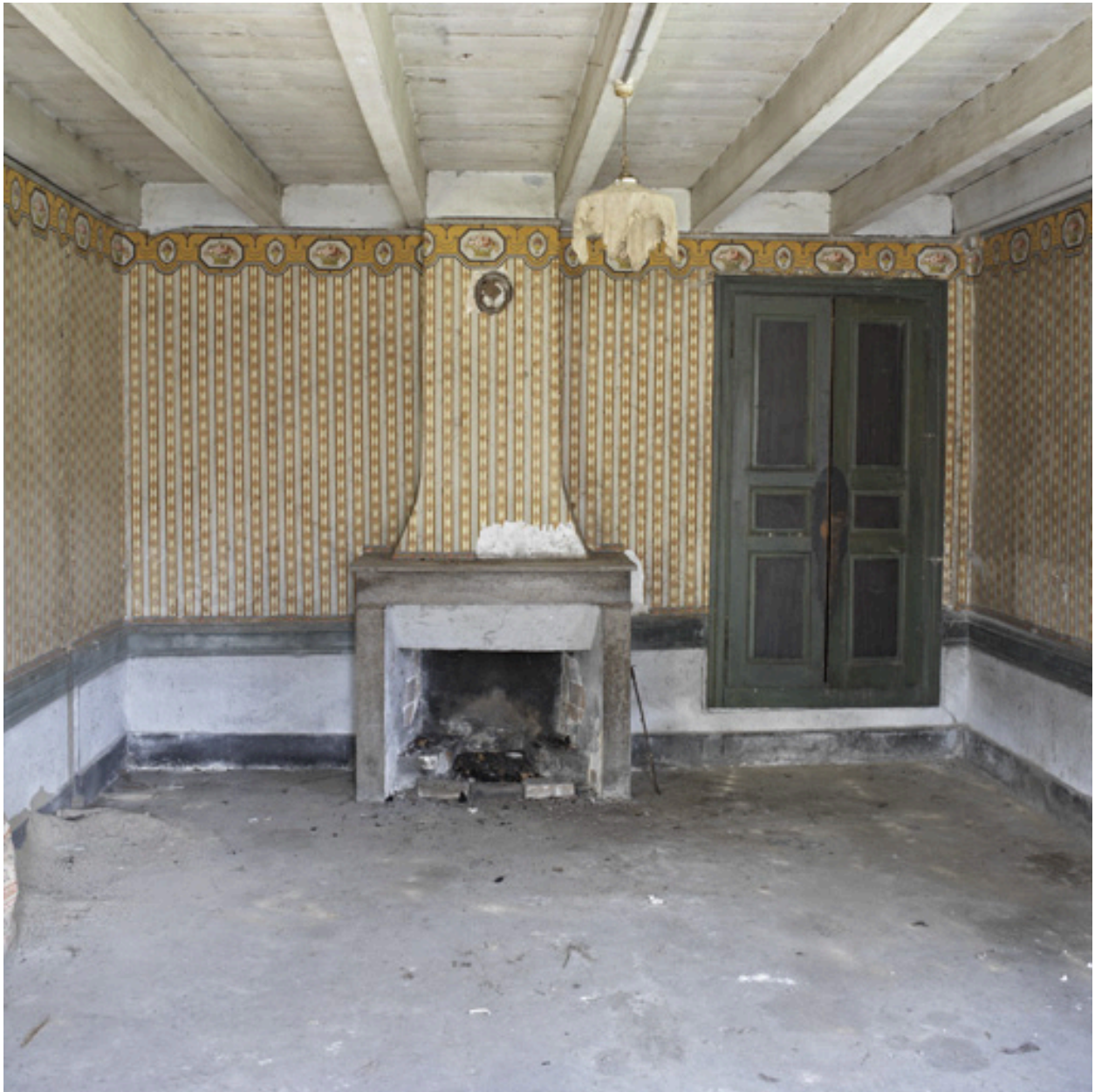
Logis nouveau, salle à manger. Vue d'ensemble avec la cheminée contre le mur ouest.
