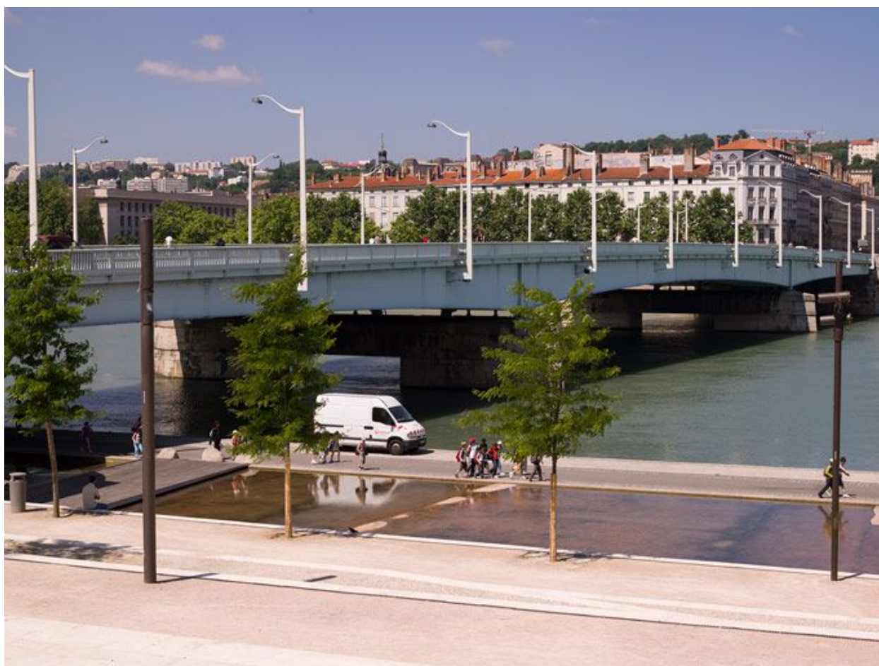
Le pont depuis la rive gauche, côté amont
