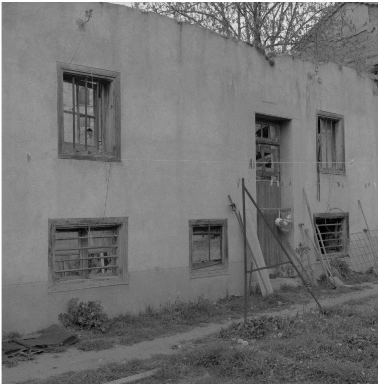
Boën, le bourg, route de Clermont, ferme (1986 AL 919). Châssis de baies utilisés horizontalement ou verticalement sur l'élévation principale du logis.
