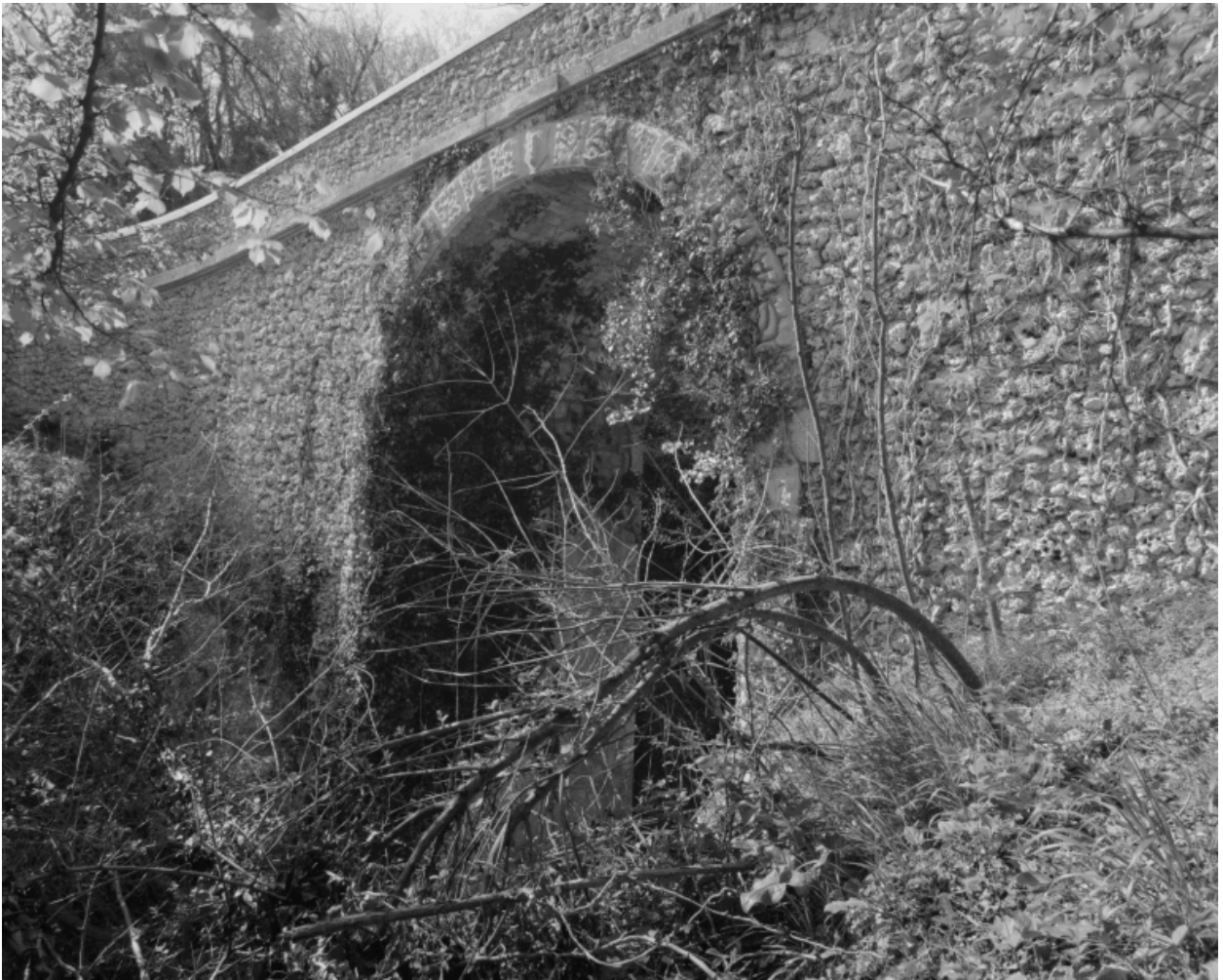
Pont sur le ruisseau de Flamenche. Vue générale.
