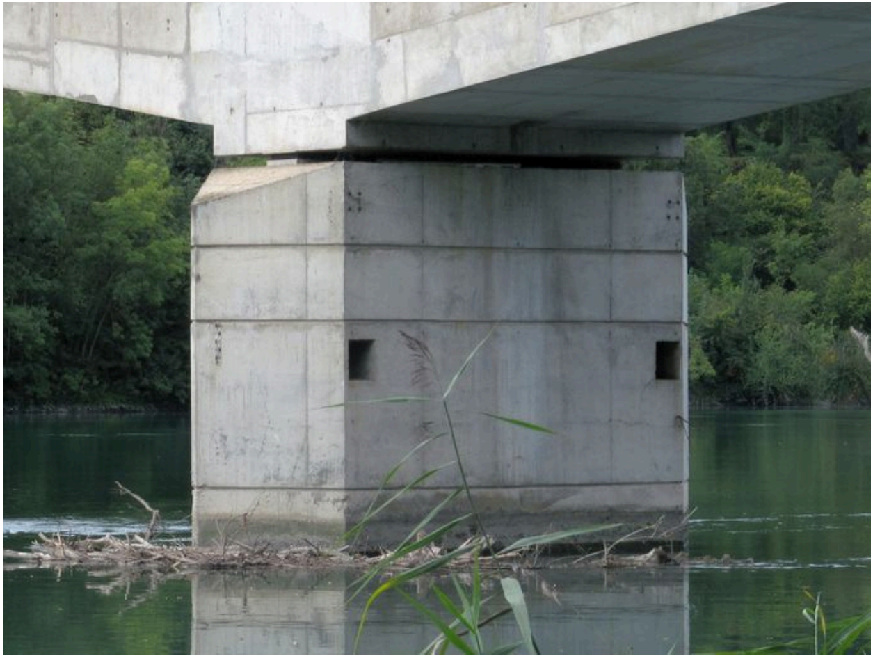
Pile, face amont (depuis la rive droite)
