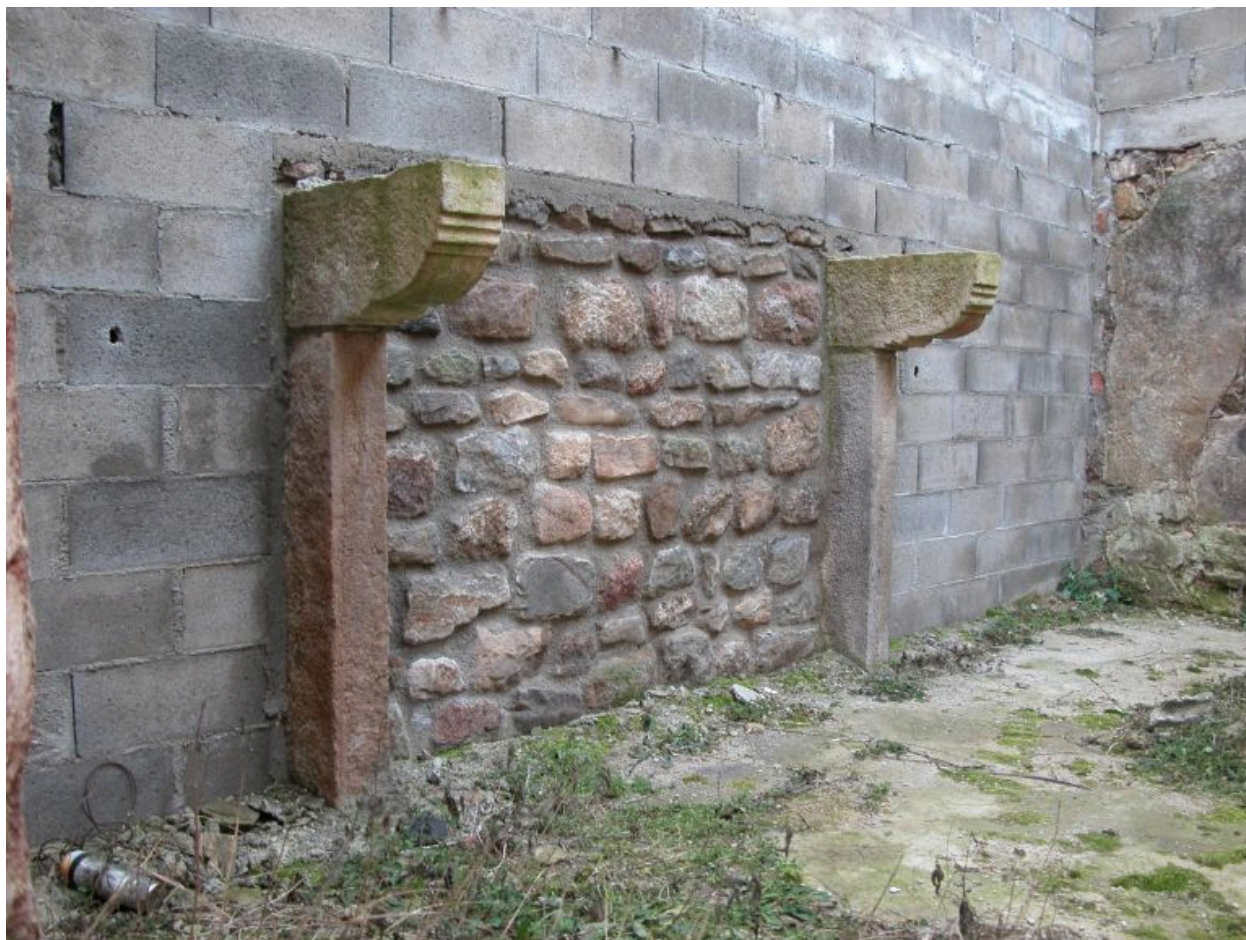
Vue d'ensemble de la cheminée de la pièce latérale gauche.
