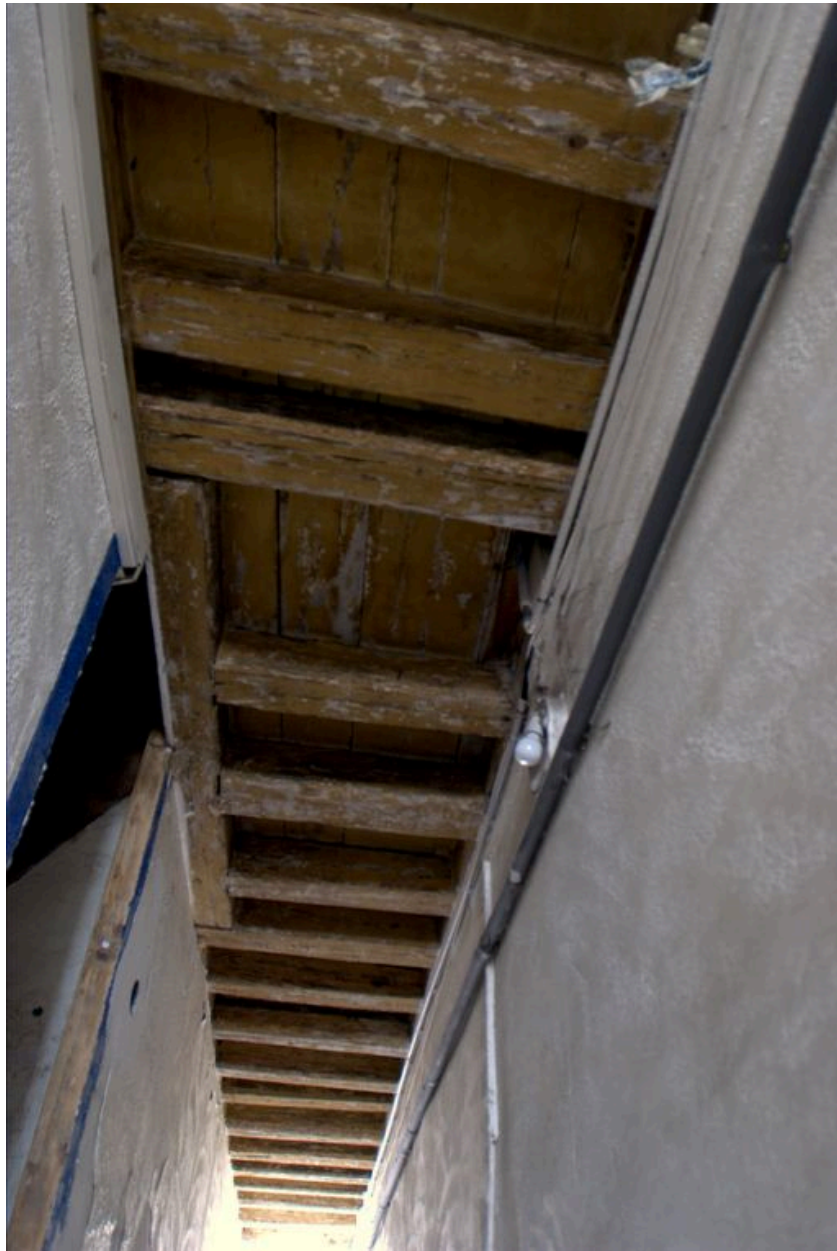
Le plafond à solives du couloir d'entrée
