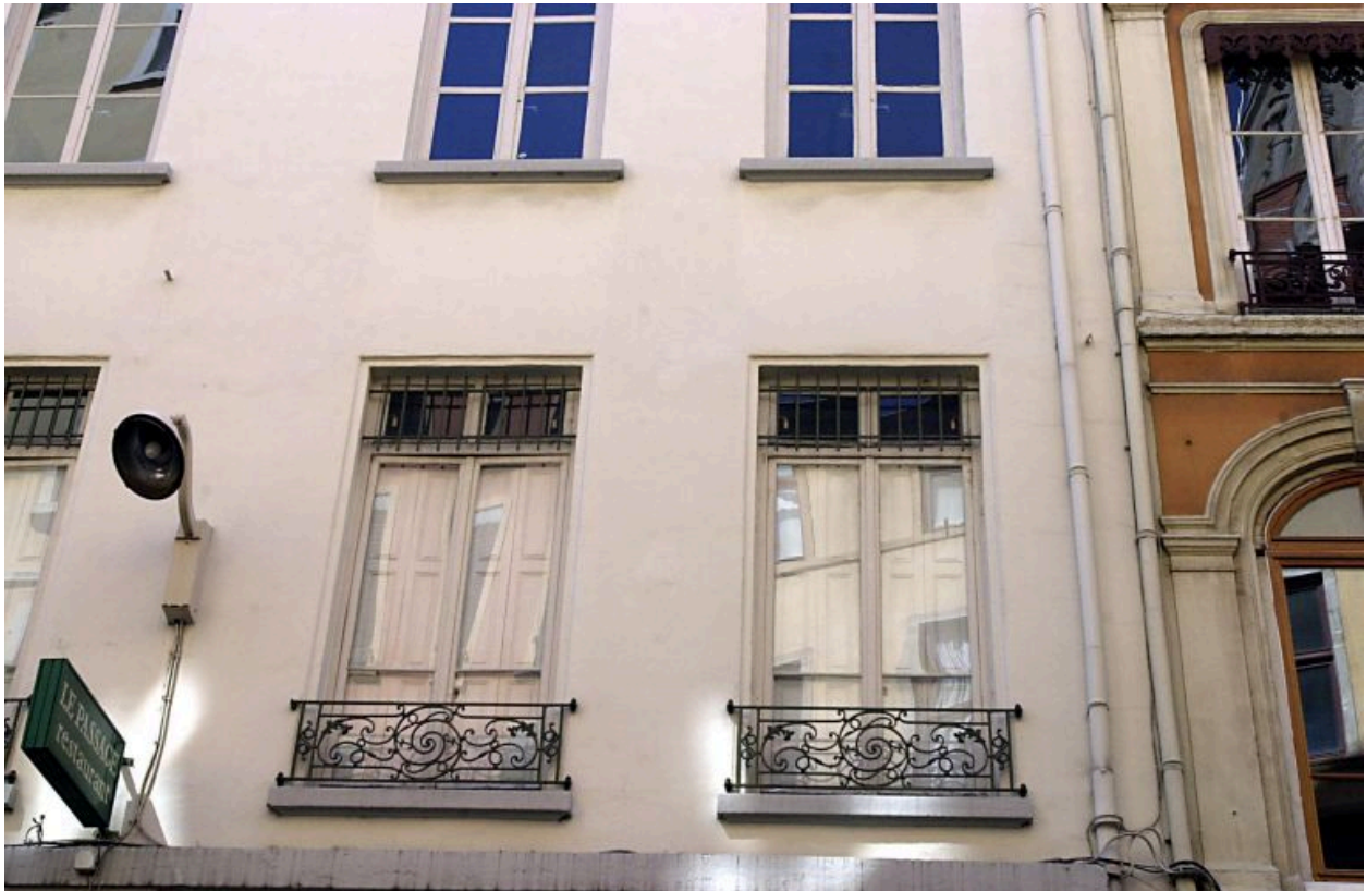
Façade sur la rue du Plâtre, détail des fenêtres du 1er étage
