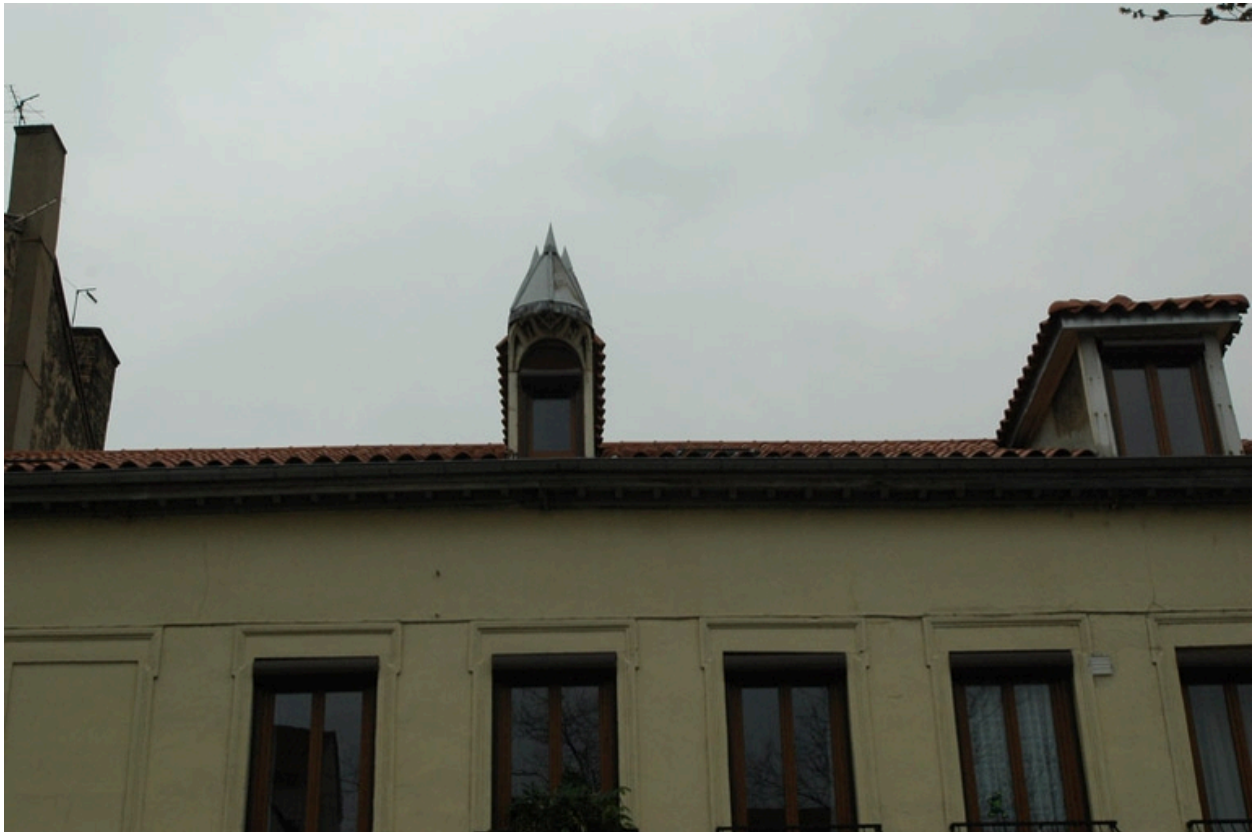
détail de lucarne, façade principale rue Etienne Richerand.
