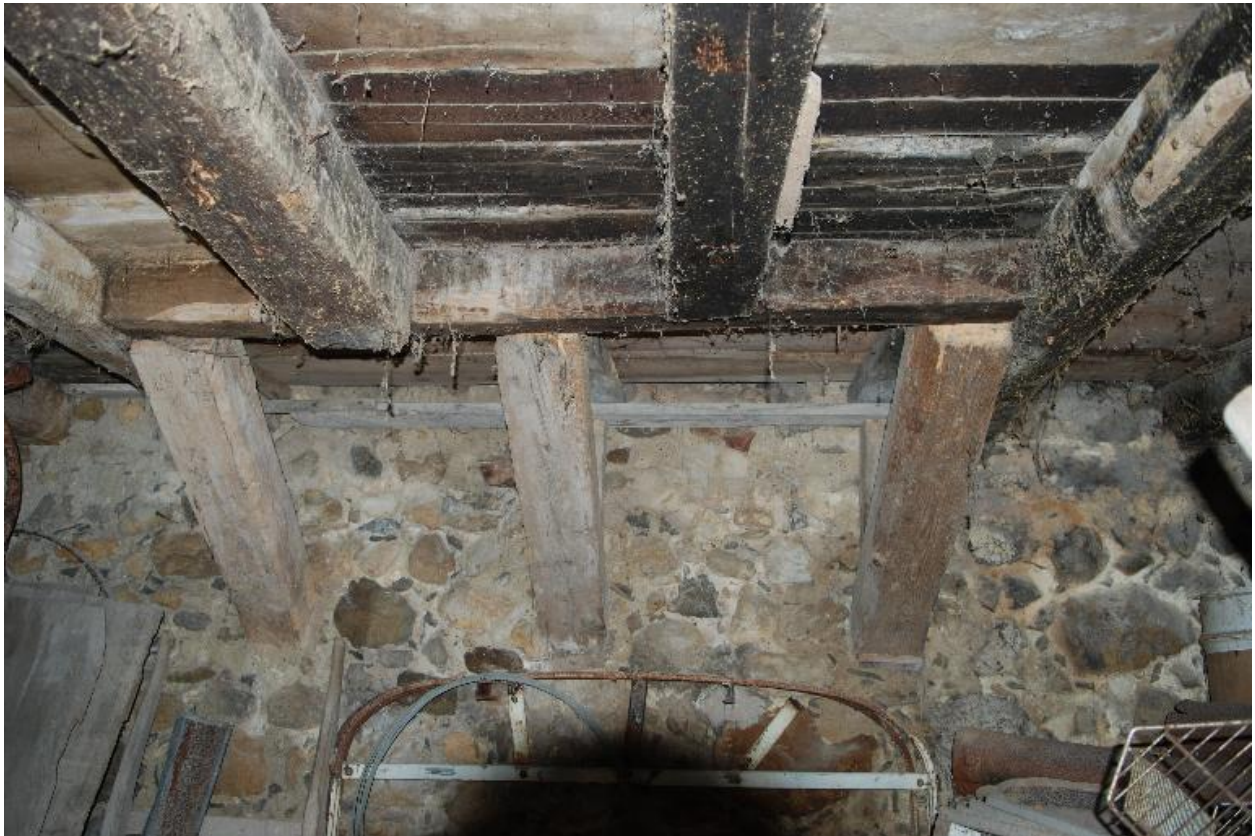
Second étage de soubassement de la partie moulin, détail des poutres de soutien de la cheminée située au rez-de-chaussée surélevée.
