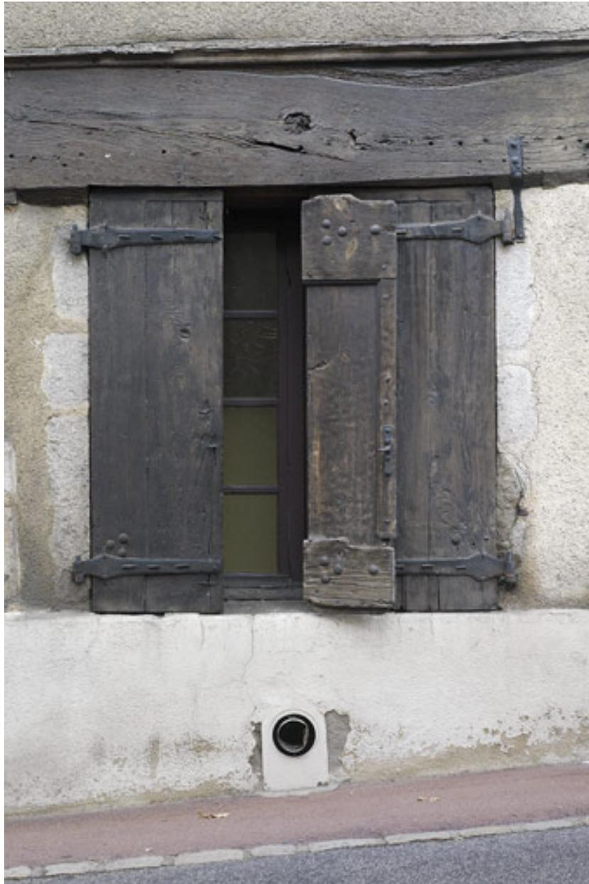
Rez-de-chaussée : la poutre sablière sert de linteau de fenêtre.
