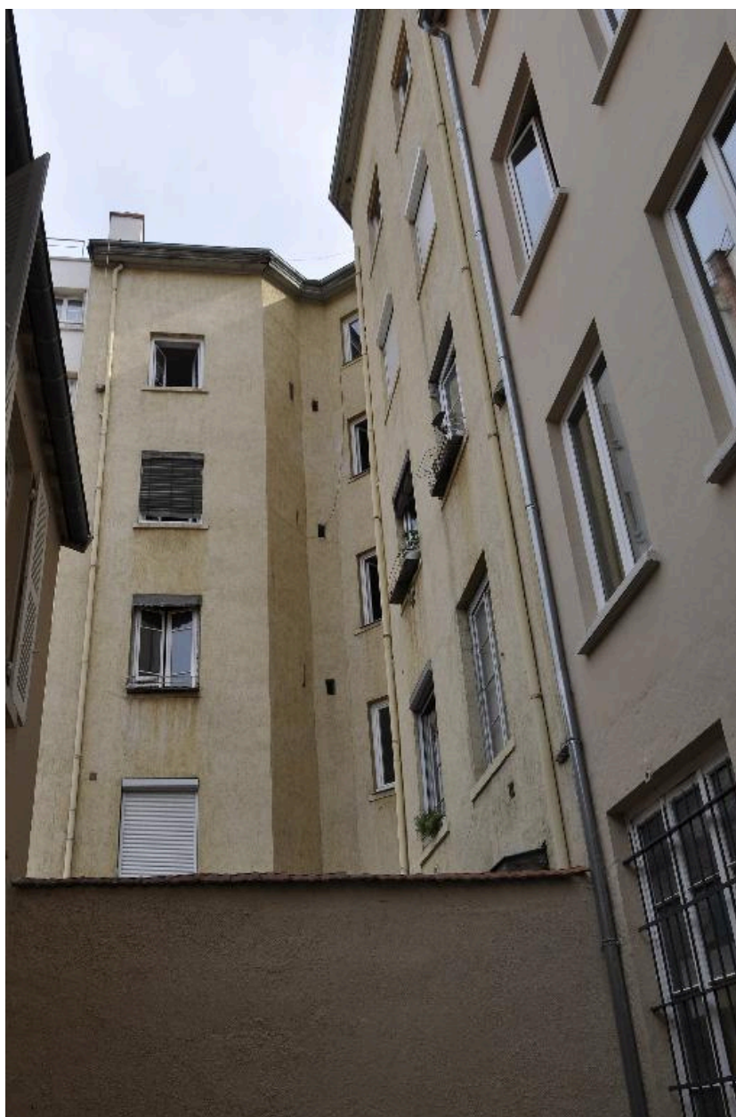
Vue partielle des élévations sur cour
