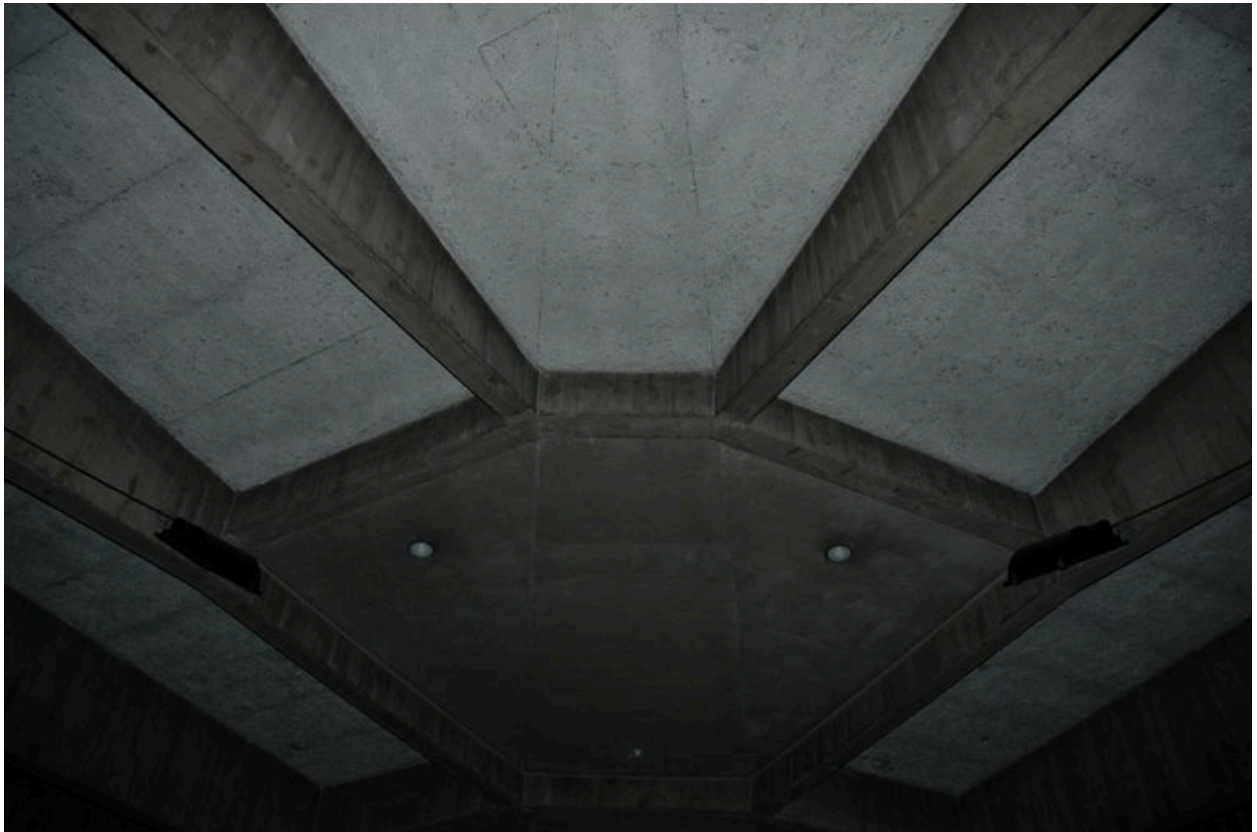
Détail du couvrement de la nef depuis les tribunes
