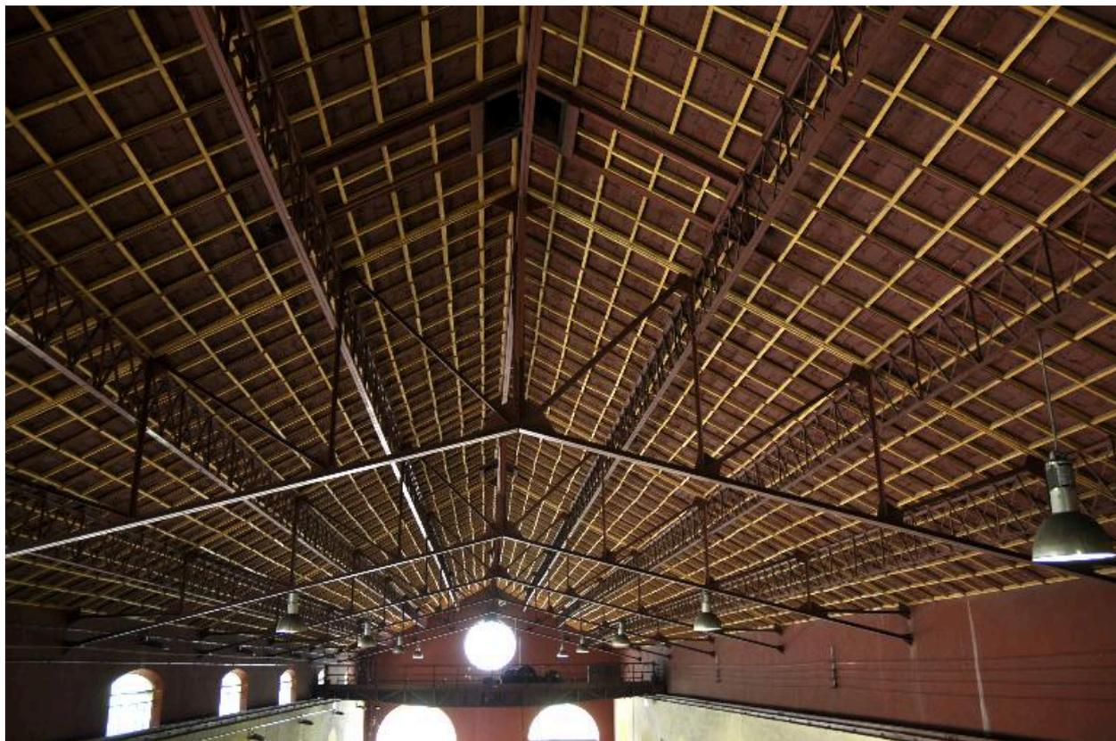
Vue de la charpente métallique et des fermes à entrants brisés
