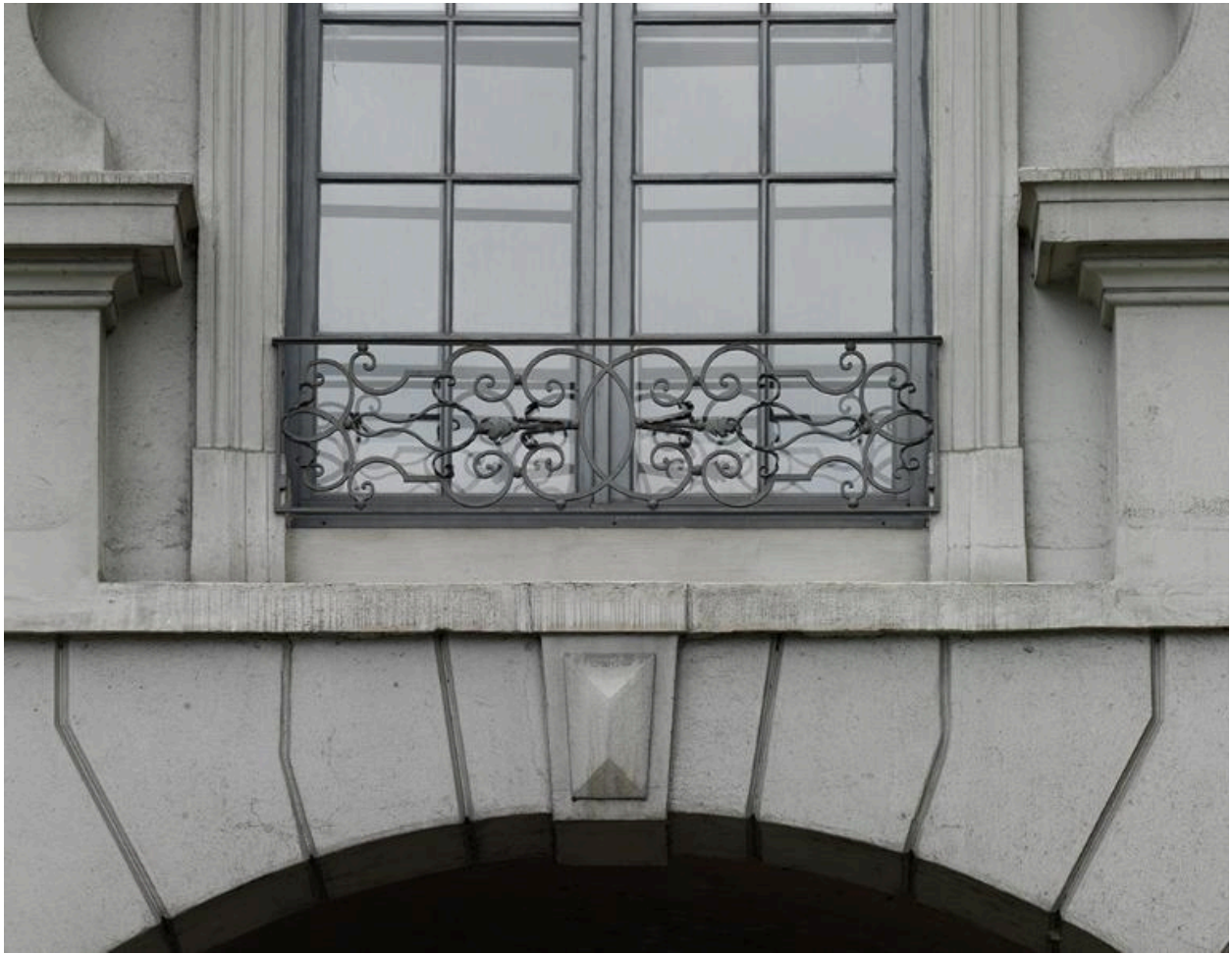
Elévation postérieure, baie au-dessus du passage Ménéstrier : détail du garde-corps
