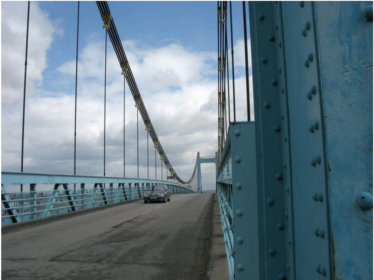
Sur le tablier, vue des voies de circulation routière
