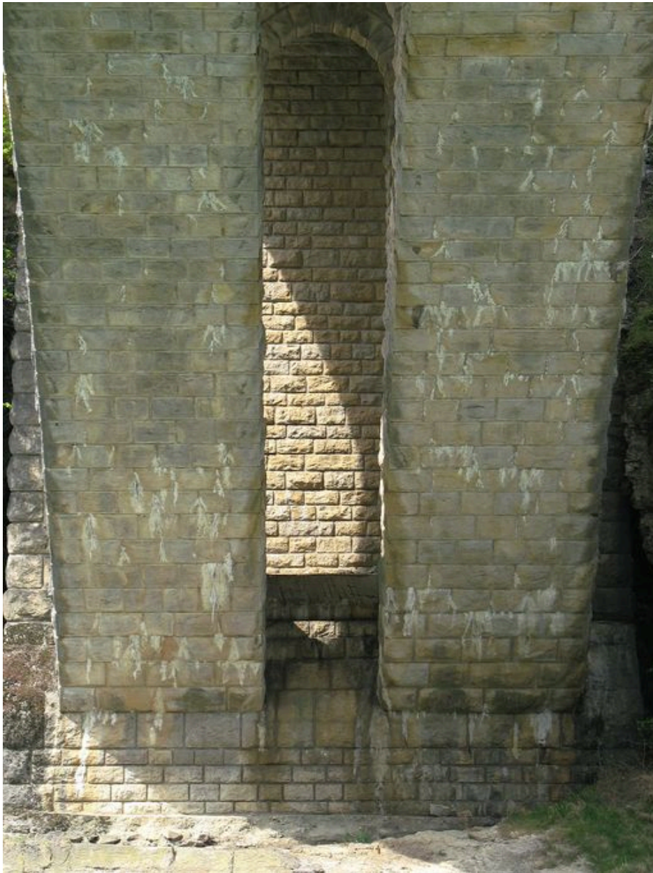
Dessous de l'arche : vue partielle, rive droite
